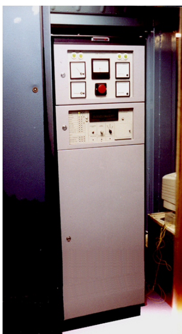
Рис. Цифровой регулятор возбуждения для бесщеточной системы возбуждения
